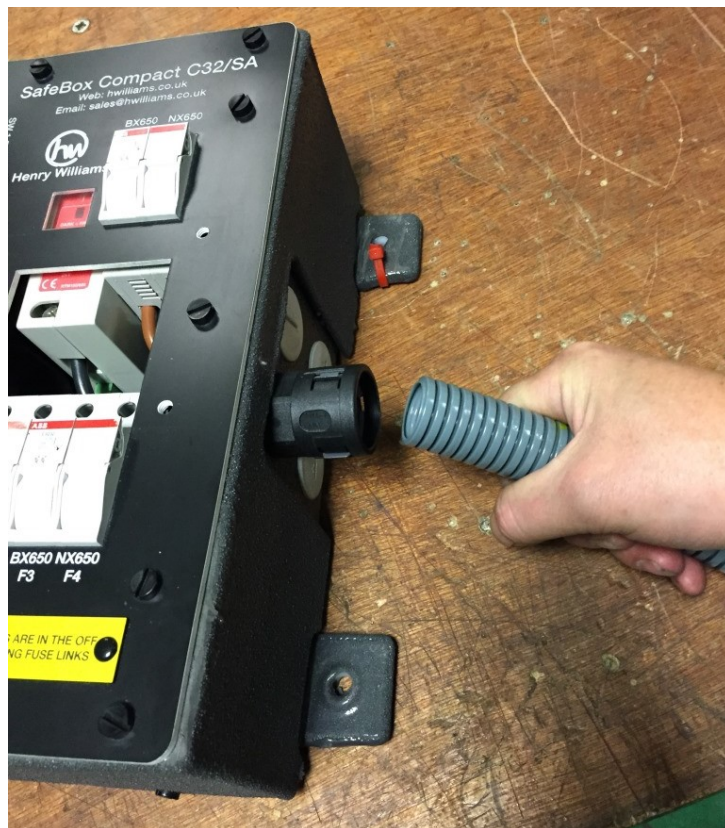
Figure 14: Fitting of Conduit Gland & Conduit
