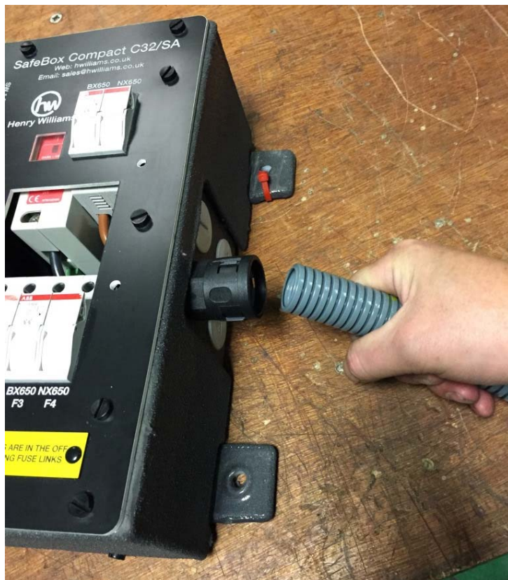
Figure 14: Fitting of Conduit Gland & Conduit
